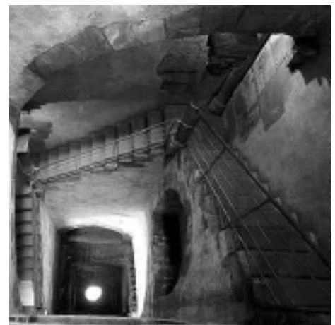
Abb. 90 Gegen 1260 entstand die Mikwe in Friedberg, Hessen. Eine siebenläufige Treppe mit 72 Stufen führt in den 5,5 m breiten und 25 m tiefen Schacht hinab, der bis zum Grundwasserspiegel reicht. vgl. auch Anm. 66
