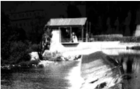
Abb. 99 Laufwasserkraftwerk mit einer Leistung von 200 kW bei einer Fallhöhe von 2,1 m, Schwäbisch-Gmünd 1988-90
