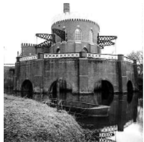
Abb. 27 Polderpumpwerk „Crucius“ am Harlemermeer. Steter Kampf um Land mit Dampfkraft.
