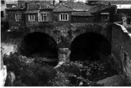
Abb. 2 Die „Rote Halle“ von Pergamon ist über einem kanalisiertem Fluß gebaut. Im Sommer ist der Doppeltunnel im Untergrund trocken. Im Winter dagegen ist er voll von reißendem Wasser. Architektur als Werkzeug zur Domestikation des Wassers. Die Bebauung auf dem Tunnel ändert sich, aber der Tunnel versieht noch nach Jahrtausenden seinen Dienst.
