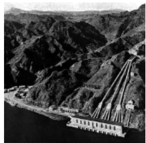
Abb. 96 Wasser ist ein idealer Energiespeicher. In der Nacht wird es auf den Berg gepumpt und in den Stoßzeiten geht es den umgekehrten Weg zurück durch die Turbine.
