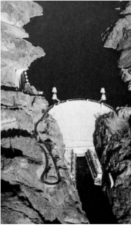
Abb. 50 Der Hoover- Damm: 3,5 Millionen Kubikmeter Beton stemmen sich gegen den Colorado-River. Die Staumauer ist über 200 Meter hoch. Mit letzter Kraft erreicht der einst gewaltige Fluß den Kalifornischen Golf.
