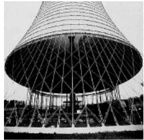
Abb. 95 Der 1976 in Hamm gebaute Trockenkühlturm wurde 1991 gesprengt und das besondere Kühlverfahren nicht weiterentwickelt. Statt dessen gilt die Konstruktion als Vorbild für Aufwindkraftwerke, die in Planung sind.
