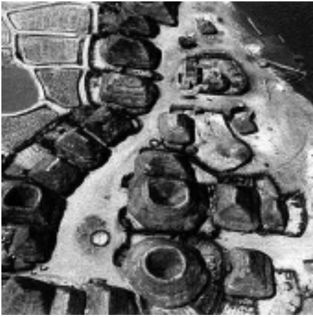
Abb. 46 Traditionelle Häuser in Senegal. Das Dach macht kostbares Regenwasser nutzbar für die Bewohner der Siedlung, die unmittelbar neben dem unbrauchbaren Salzwasser liegt.
